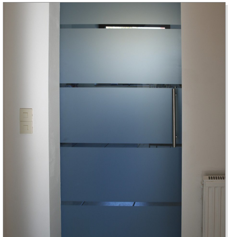
9570 Tür zur Küche
