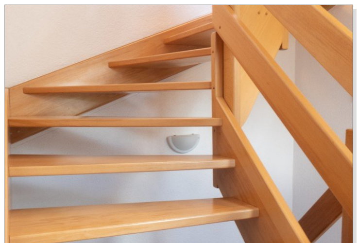
9586 EG TREPPE ZUM DG Neubau
