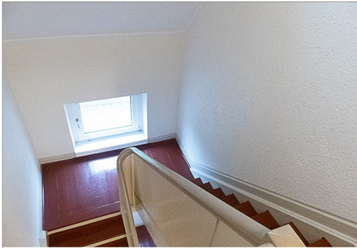
9857 DG Treppenhaus B1
